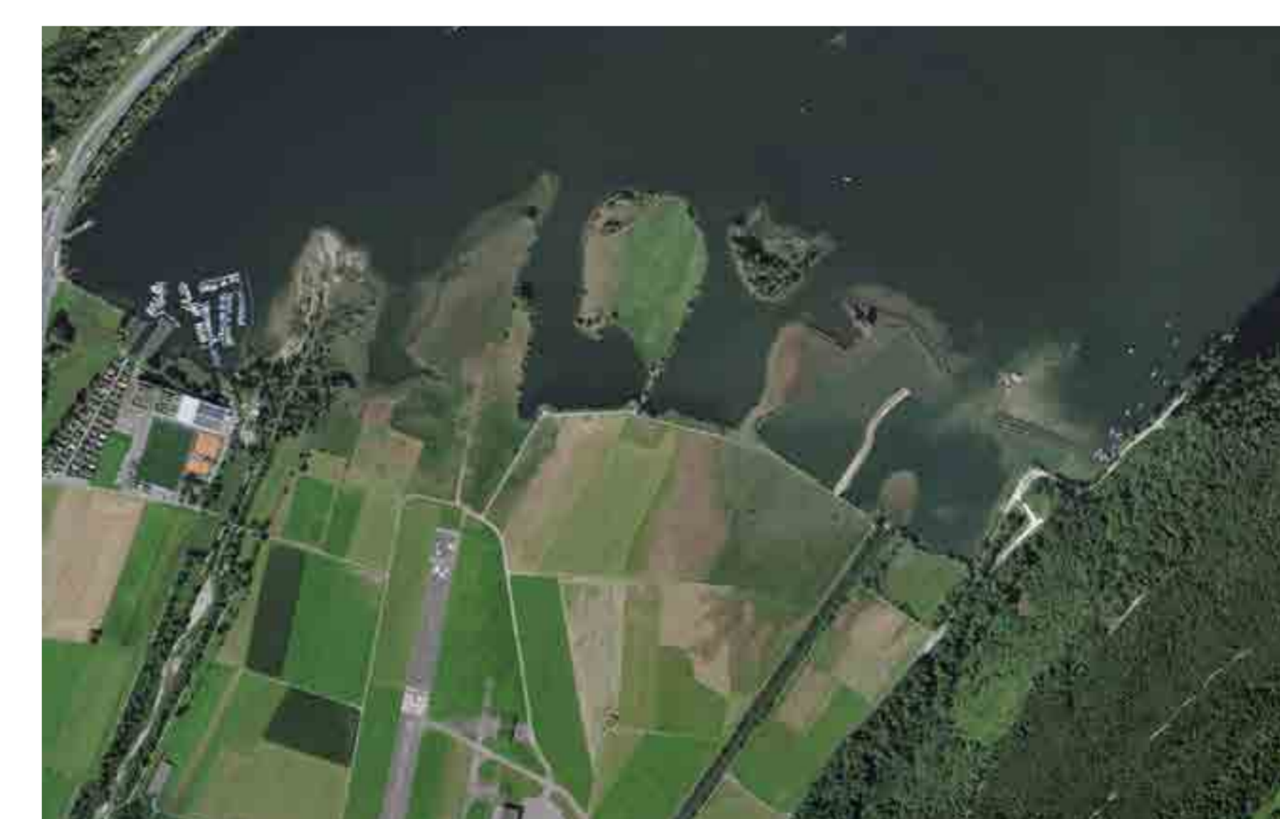
Luftbildaufnahme von 2021: Gut sichtbar ist der bereits erstellte Damm mit wasserbeständigem Material aus der Kraftwerkserneuerung Ritom TI. Westlich davon erfolgen die Schüttungen mit Ausbruchsmaterial aus dem Stollen. Bild: map.geo.admin.ch
