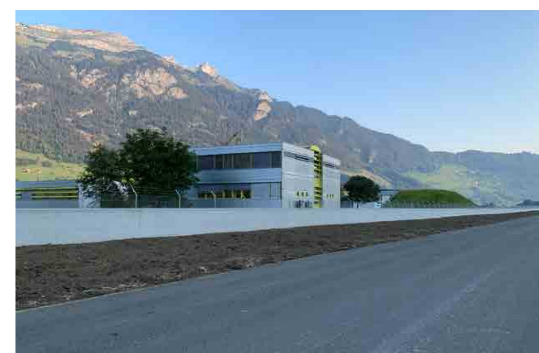
Der Hochwasserschutz für die Hauptgebäude des Flugplatzes Alpnach wird mit einer rund 800 Meter langen Schutzmauer gewährleistet. Bild: Kanton Obwalden
