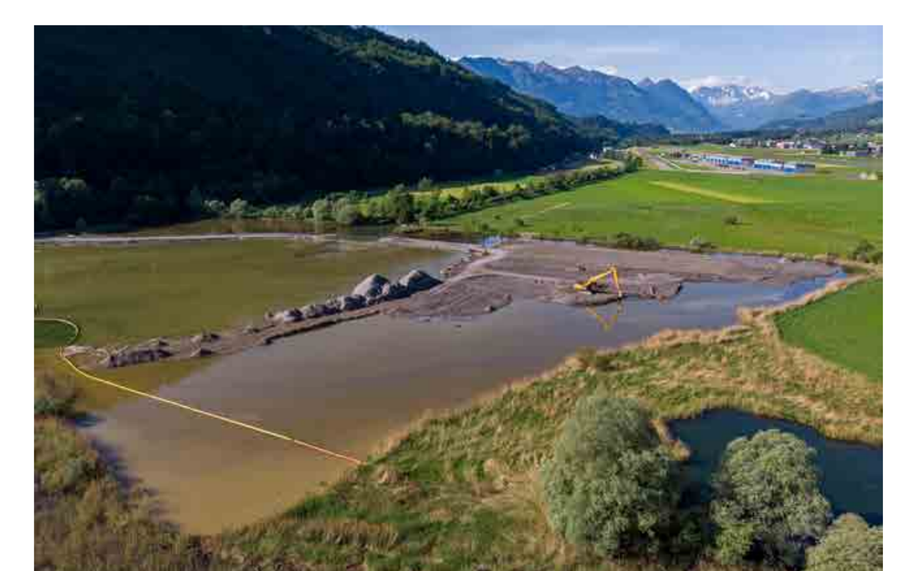
Das überschüssige Aushub- und Ausbruchmaterial aus dem Hochwasserentlastungsstollen sowie Material des Projekts Kraftwerkerneuerung Ritom (Tessin) können beim Südufer des Alpachersees umweltgerecht und kostengünstig verwertet werden. Bild: durrair.ch
