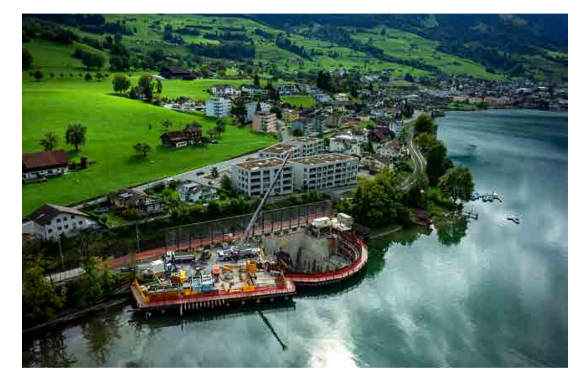
Die 80 Meter lange Zielröhre beim Einlaufbauwerk in Sachseln wurde im Sprengvortrieb ausgebrochen. Bild: durrrair.ch
