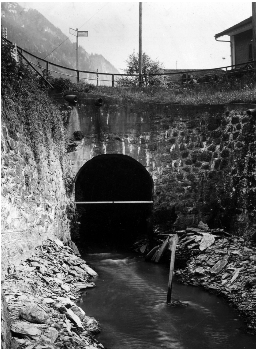
Bild 4: Alter Stollenauslauf Richtung Norden, wie er im Jahre 1767 erstellt wurde. Die Sohle des Stollenauslaufes wurde im Jahre 1850 bei der Entsumpfung des Aarieds ca. 1 m tiefer gelegt um das Gefälle zu erhöhen. Im Jahre 1900 wurde hier Wasser ausgeleitet zum Betrieb einer Uhrensteinschleiferei sowie zur Stromerzeugung für das Hotel Krone. Der Bauschutt im Vordergrund sind die Überreste des Kanals. Dieser musste beim Ausbau des Lungernersee - Kraftwerkes im Jahre 1923 beseitigt werden. Kurz nach dieser Aufnahme wurde das Profil des Stollens wesentlich vergrössert.
