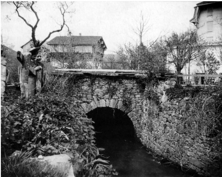
Bild 5: Alter Stolleneinlauf Richtung Süden, wie er im Jahre 1767 erstellt wurde. Im Hintergrund das Heimwesen Talacheri. Bis dort wurde der Stollen im Tagbau erstellt und später wieder mit Erdreich überdeckt. Hier, wie auch am Nordportal, wurden die ausgebrochenen Steine der Burgruine Rudenz verbaut.
